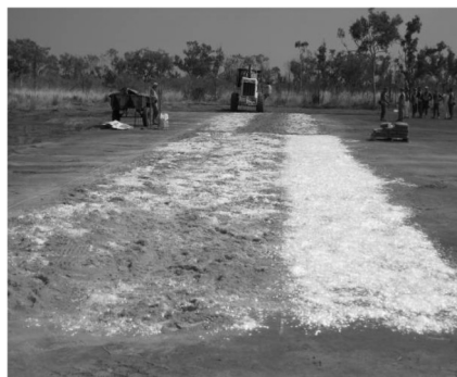
شکل ۴ - مراحل اجرای تثبیت خاک بستر فرودگاه توسط الیاف پلی
